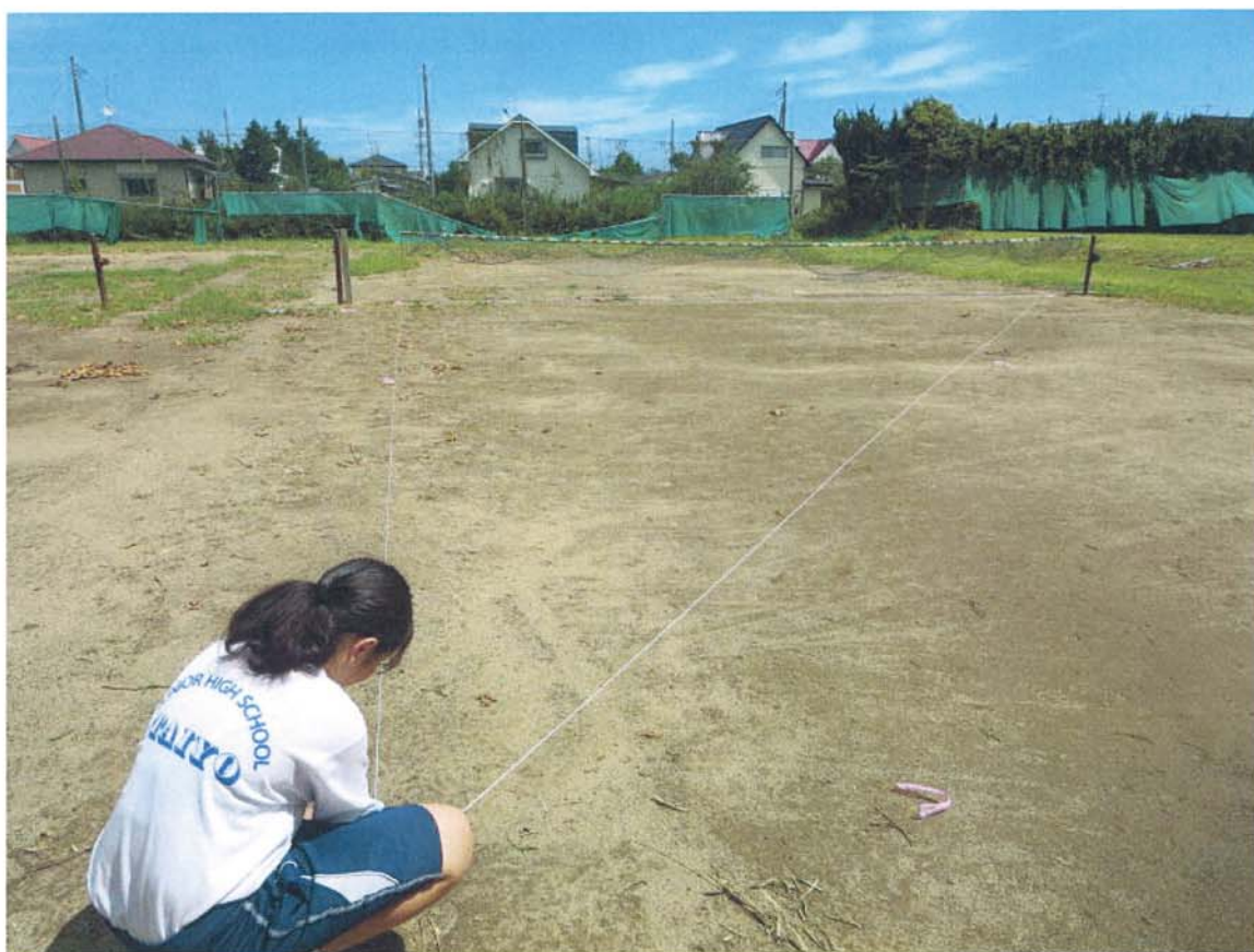
ピタゴラ巻き尺を使って作業をしているところ
