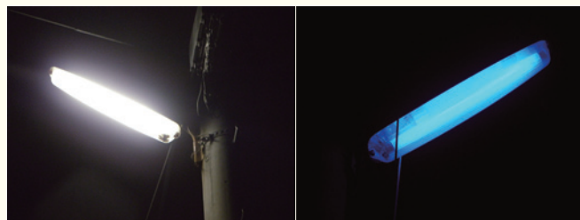
図5 白色蛍光灯 (左) と青色蛍光灯 (右) の防犯灯
